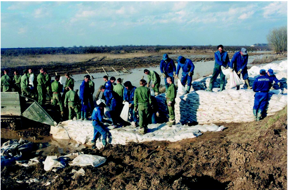
Bordás megtámasztás készítése honvédségi segítséggel
