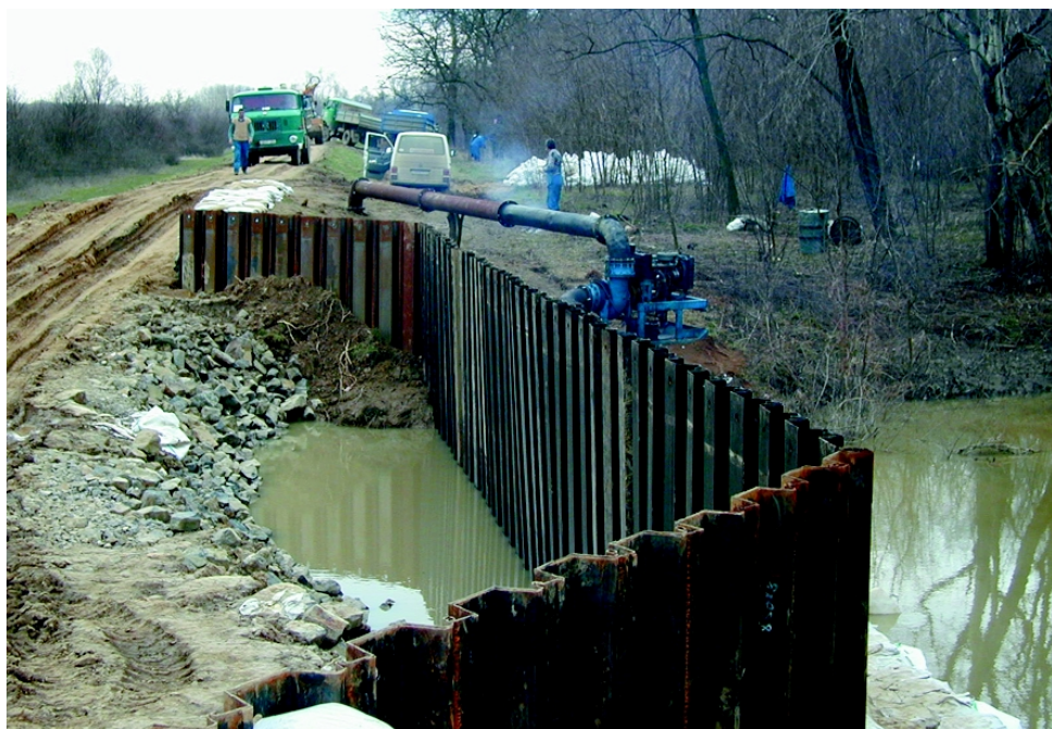
Elkészült a Túr bp. 12+000 tkm szelvény szádófalas elzárása
