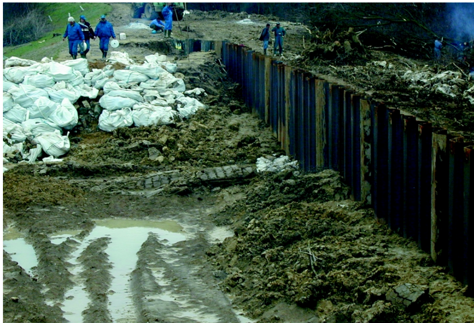
Elkészült a Túr bp. 12+400 tkm szelvény szádófalas elzárása
