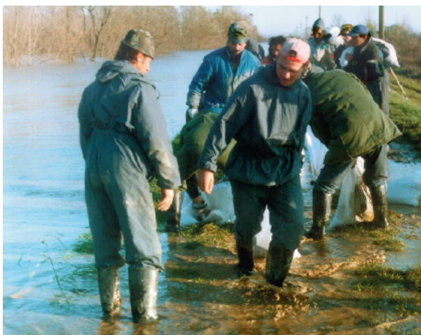
Töltésmagasítás koronán átbukó víz mellett
