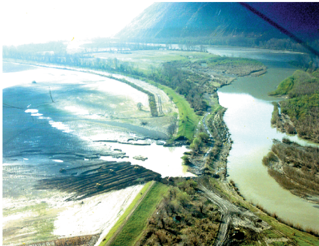
1998. november 5-én 14.00-16.00 között keletkezett töltésszakadás Királyháza alatt (Ukrajnában)
